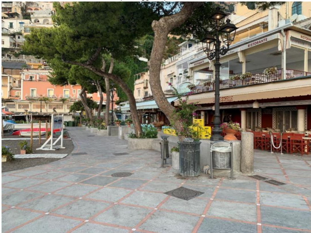
Lato su cui si concentra la principale attività di scavo per l'interro dei nuovi impianti
