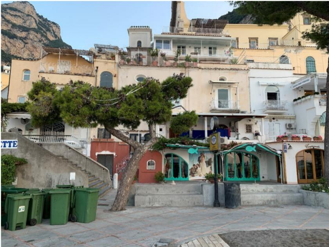
Lato ovest-sulla sx la scala che collega Via Regina Giovanna e Via Marina Grande
