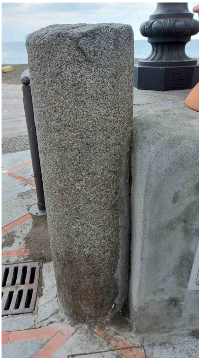
Colonna di granito lato ovest rotonda spiaggia grande
